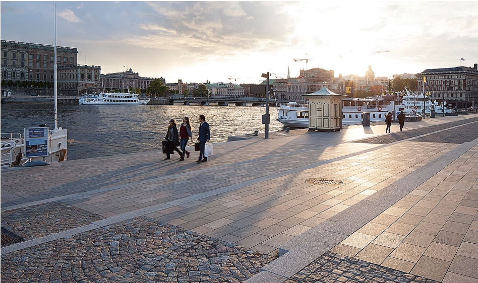
Figur 8-7. Strömkajen i Stockholm (mitt emot Kungl. Slottet), som efter ett århundrade måst sänkas för att motverka landhöjningen och fortsatt passa till skärgårdsbåtarna; därav den trappstegsformade sluttningen mot vattnet.
