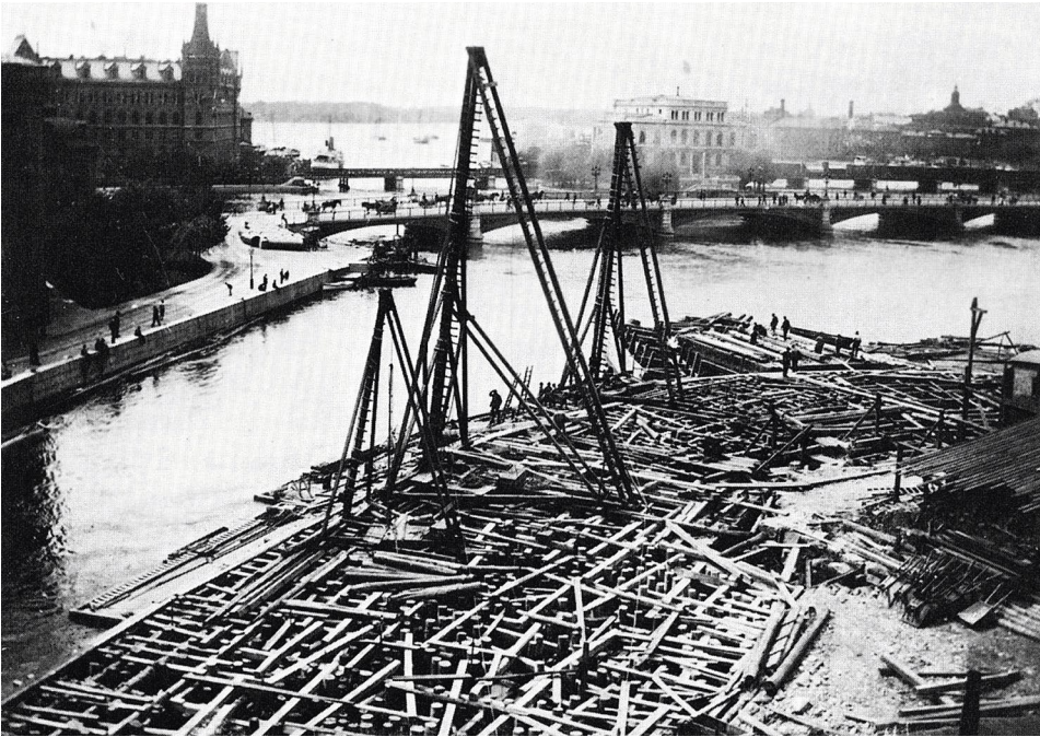
Figur 8-1. Pålning till grunden för riksdagshuset i Stockholm 1897. Dessa pålar har sedan dess gradvis lyfts upp ur vattnet av landhöjningen, vilket krävt en speciell aktion för att rädda riksdagshuset.
