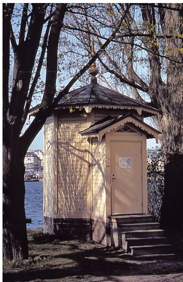
Figur 5-10. Mareograf för kontinuerlig registrering av vattenståndet i havet; sådana började anläggas 1887.
