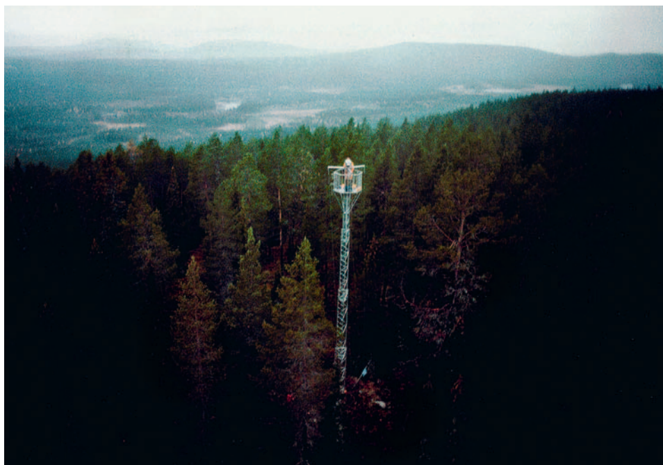
Figur 6-18. Trianguleringstorn av lättmetall i tredje rikstrianguleringen, 1970-talet.
