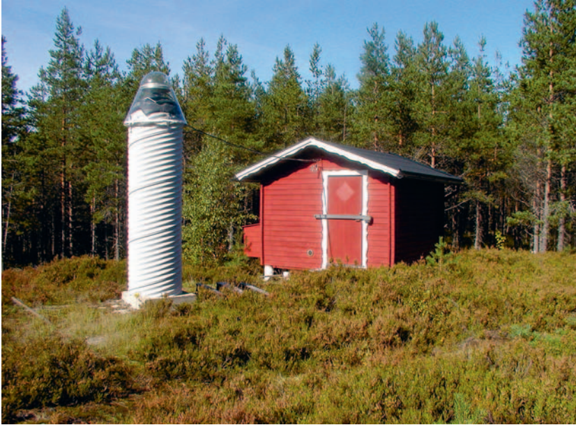
Figur 7-2. Fast referensstation för satellitpositionering av den typ som började upprättas 1993.
